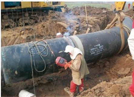
图1 焊接工程现场图
