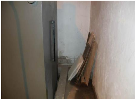
图9 设备间堆放杂物
