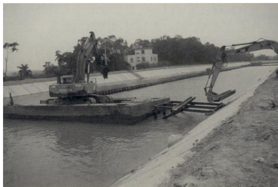
图2 钢板桩拆除示意
