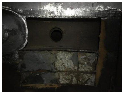
图3 尾水管损坏情况
