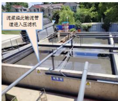
图5 泥浆由泥浆池进入压滤机
