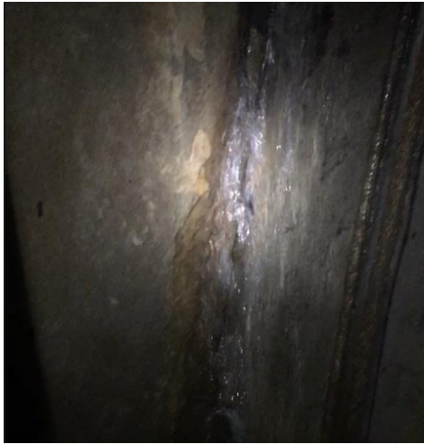
图 1 压力钢管漏水
