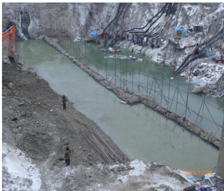
图 7 钢筋砂砾石笼形成的“模板”
