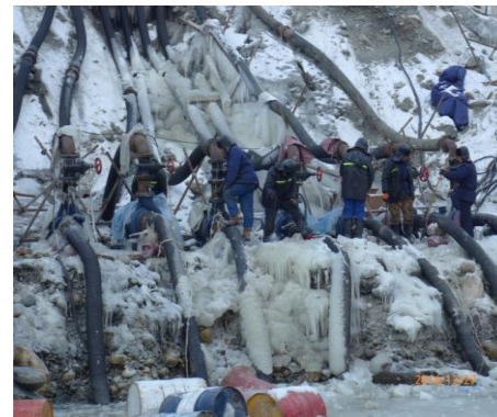
图 6 抽水排水明渠
