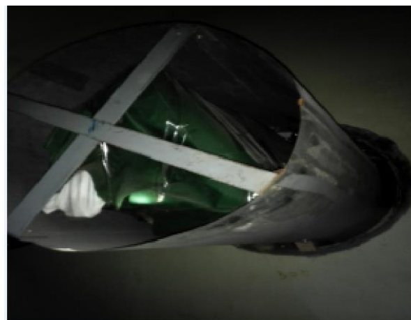
图 3 电气贯穿件的保护套筒
