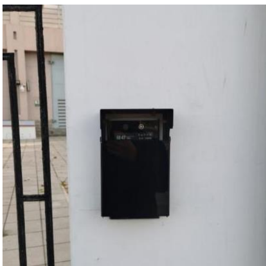
图2 现场门禁硬件改造实拍图
