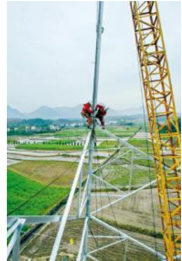
图1 高塔组立施工
