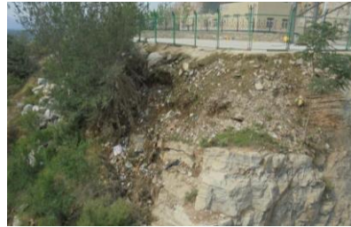
图6 总干渠漕河渡槽出口拦网清出杂物
