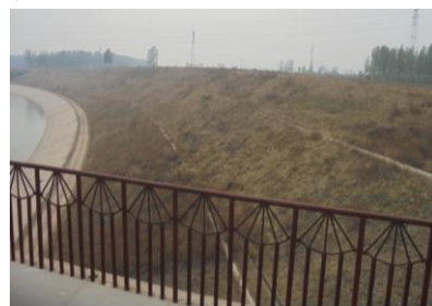
图8 总干渠唐县段岸坡枯草及植物秸秆
