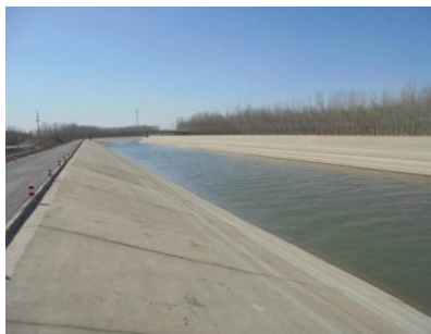
图1 分水口门附近总干渠表面无杂物
