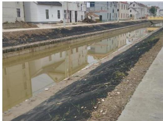
图2 三维水土保护毯护坡
