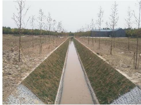
图4 绿化混凝土护坡
