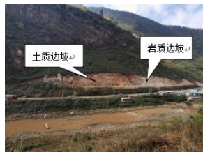
图 1 过坝公路开挖面
