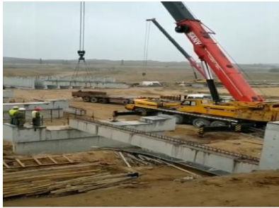
图1 水利工程提防施工维护
