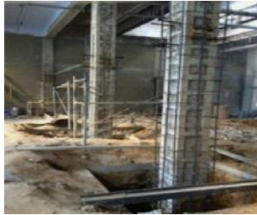
图1 准备浇筑的水利工程结构
