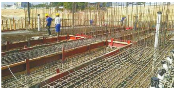
图1 水闸围堰工程施工
