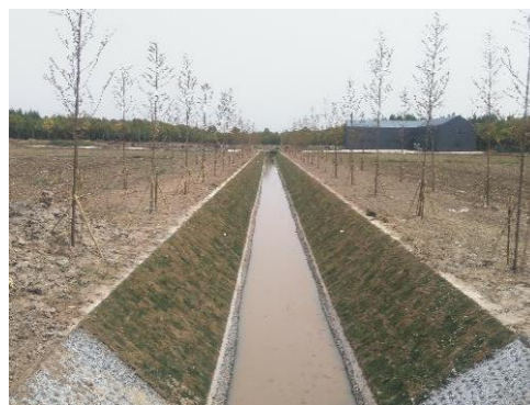
图4 绿化混凝土护坡
