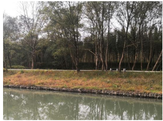
图10 格宾石笼护岸治理后现场照片
