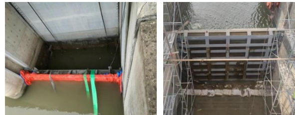
图1 挡水布+沙包围挡
