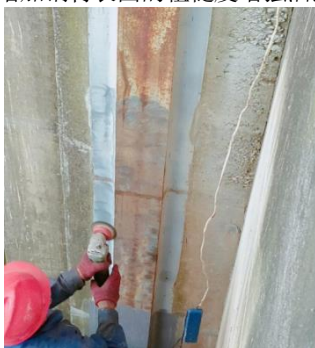
图2 门槽打磨
