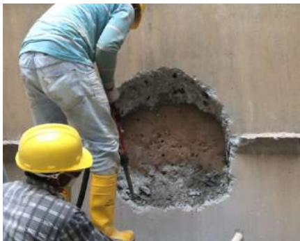
图 2.2-3 顶管始发 / 接收处工作井外地层加固效果
