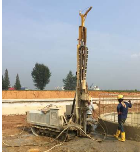
图 2.2-2 洞口地层预加固施工图
