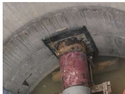
图 2.3-2 顶管始发洞口止水装置
