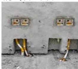
图1 水平、垂直方向管线接驳位置偏差图
