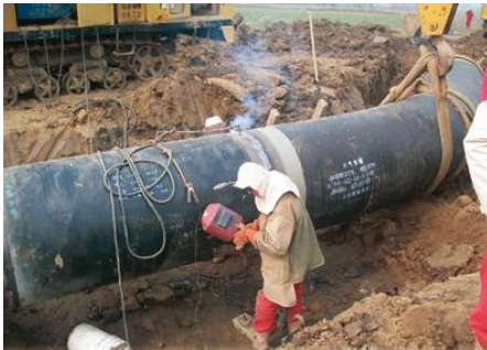
图1 焊接工程现场图
