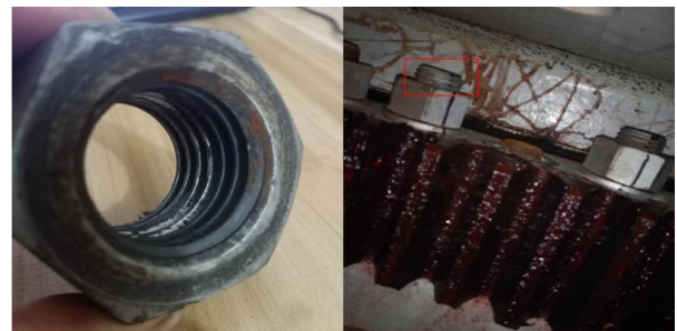
图7 螺栓润滑脂涂抹情况
