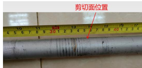
图5 螺栓光杆部分情况
