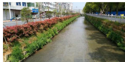
图10 宁国市小南河岸坡治理后照片
