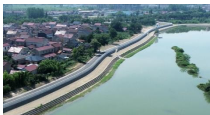
图8 水阳江汪溪段岸坡治理后照片
