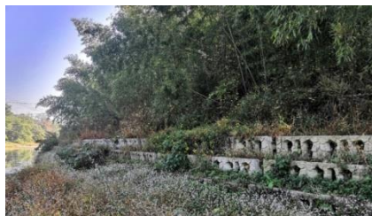
图9 宁国市中溪河岸坡治理后照片
