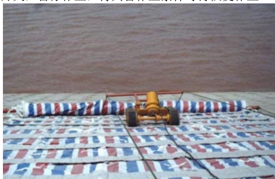
图5 水陆两用土工膜自动铺设机作业现场图
