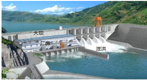
图 1 坝后式水电站示意图
