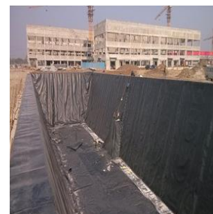
图2 水利工程中防渗膜施工现场
