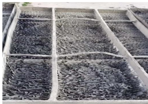
图1 #4炉空预器损坏的换热片已全部更换
