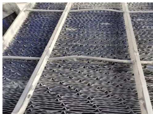
图2 #4炉空预器结灰严重的换热片进行了清洗。
