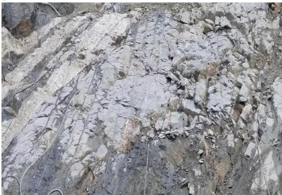
图 6 左岸 EL960~945m 槽底边坡
