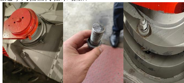
图 2 套筒螺栓断裂图
