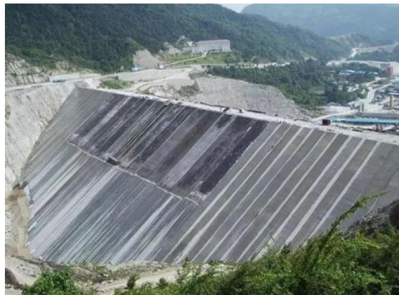
图3 土石坝施工现场
