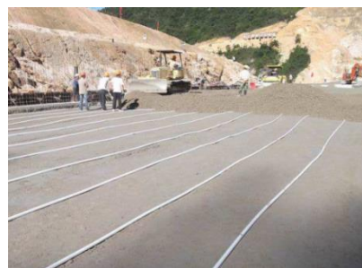
图1 大坝混凝土碾压施工现场
