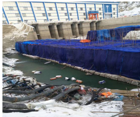
图 8 基坑上部搭设的暖棚
