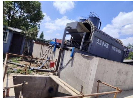
图3 淤泥吹填进滚筒筛
