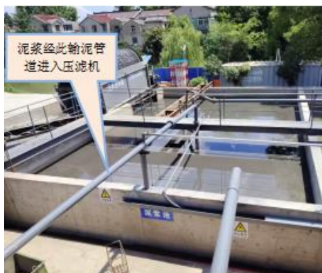
图5 泥浆由泥浆池进入压滤机
