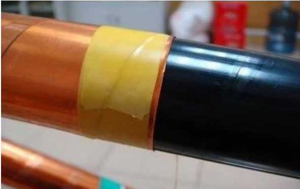
图1 铜屏蔽断口处理
