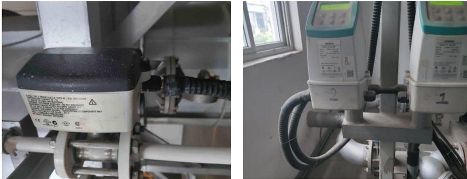
图6 电源线、励磁线和电极信号线交叉一起
