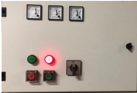
图 1 高压柜面板更换
