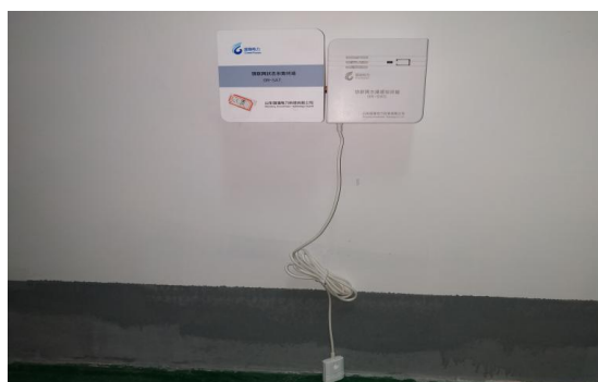
图 13 水浸传感器及控制单元
