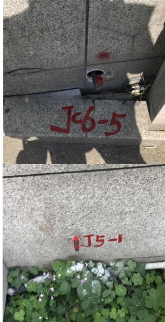
图2 建筑物监测点布置照片
