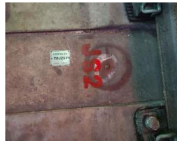
图 3 垂直位移基准点埋设示意图
