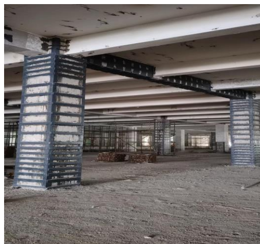
图 1 柱包钢加固施工
