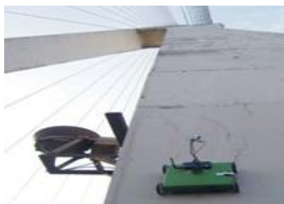
图3 使用爬壁机器人进行桥梁检测
