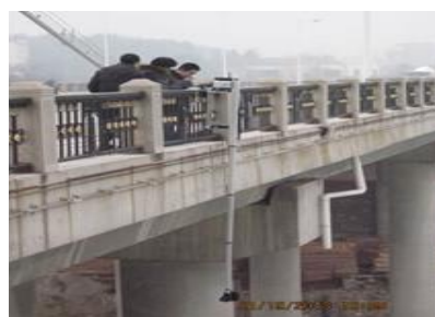
图4 使用智视系统进行桥梁检测
