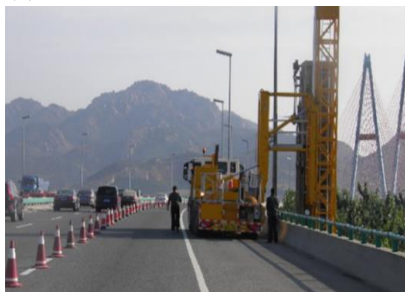
图1 使用桥梁检测车进行桥梁检测
