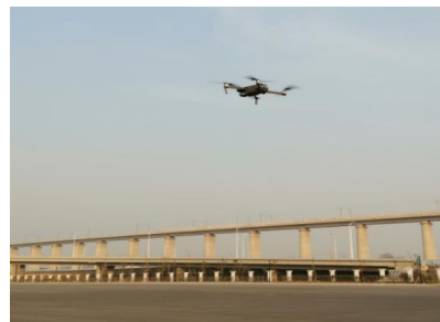
图2 使用无人机进行桥梁检测
