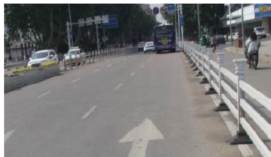
图4 桥梁现状图（二）
