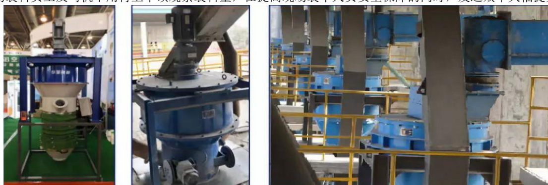
图5 散装称安装现场
