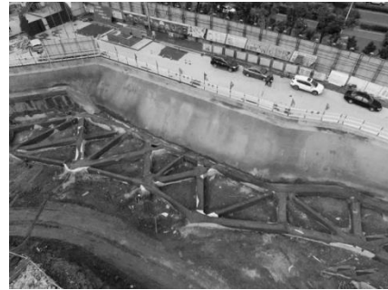
图2 基坑支护施工示意图
