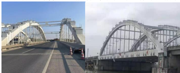
无锡市G312直湖港大桥
