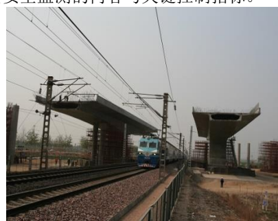
图1 转体前浇筑梁体
