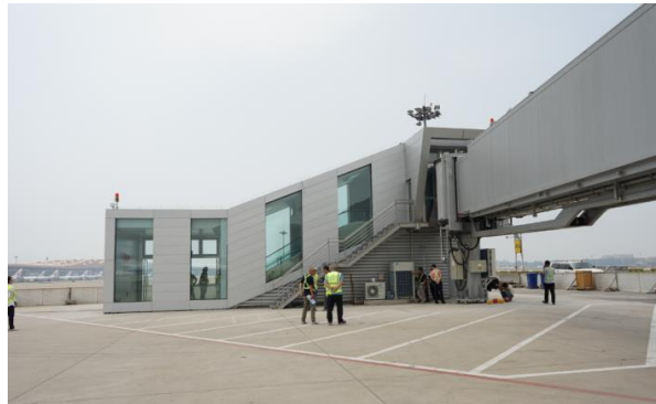
图2 首都机场 455 机位远机位登机桥 [3]
