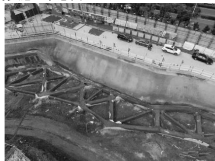
图2 基坑支护施工示意图
