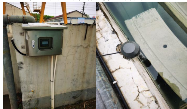
图10 水养池水温PH值采集控制柜和采集感应器
