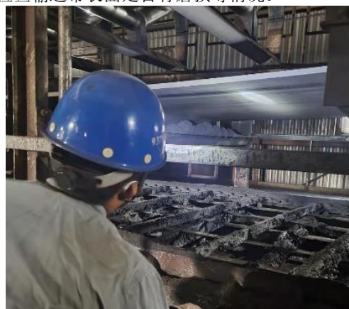
图5 输送带表面磨损检查
