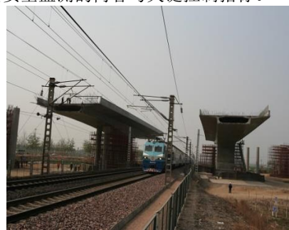
图1 转体前浇筑梁体
