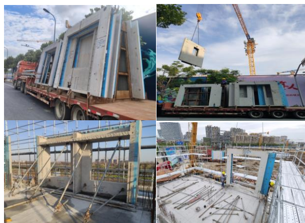
图3 双面叠合夹心保温外墙板安装
