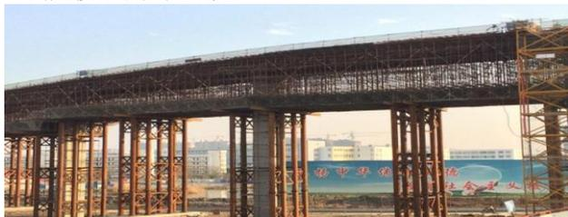
图 6 成型高支模系统少支架图
