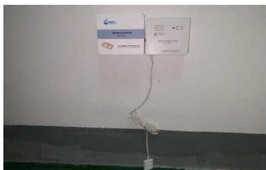
图 13 水浸传感器及控制单元
