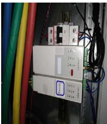
图 6 低压柜柜内无线传感器
