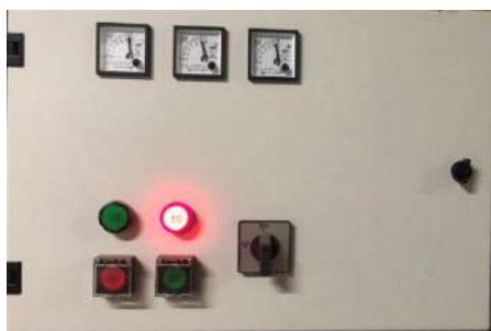
图 1 高压柜面板更换
